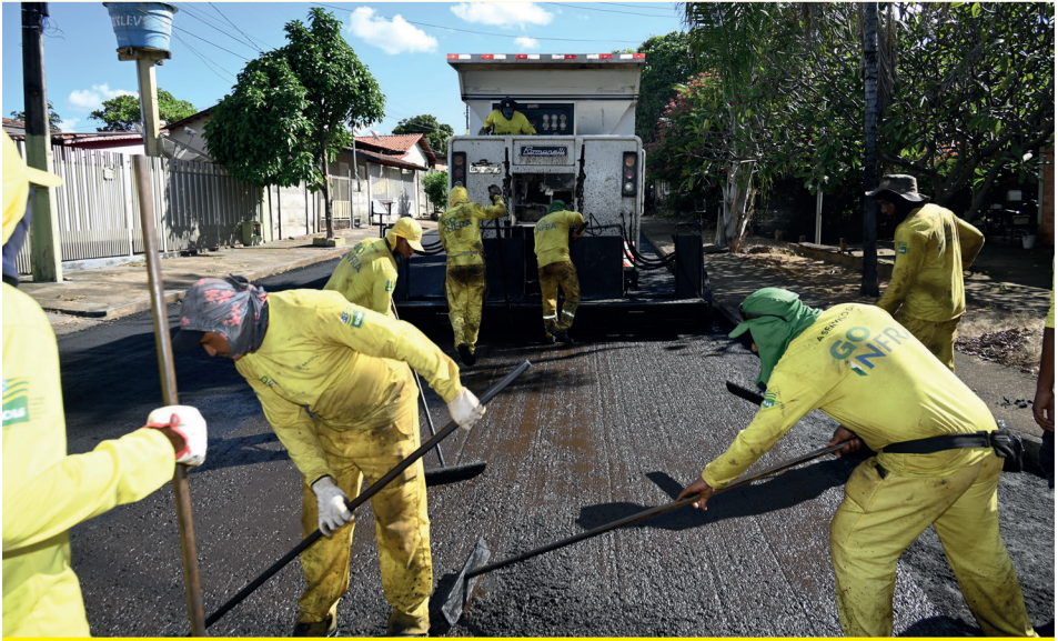
Entre 2021 e 2022, Goias em Movimento – Eixo Municípios já recuperou ruas e avenidas de 154 municípios; em 2023, programa avança para demais cidades
