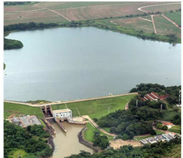
"Verifique a existência de trincas ou rachaduras e infiltrações nas ombreiras, cristas e taludes. Caso existam, deve-se reduzir ainda mais o volume acumulado no reservatório para reduzir a pressão exercida pelo volume da água", diz o superintendente. "A redução do nível da água não deve ser de mais de 15 cm por dia, para evitar escorregamentos dos taludes".
