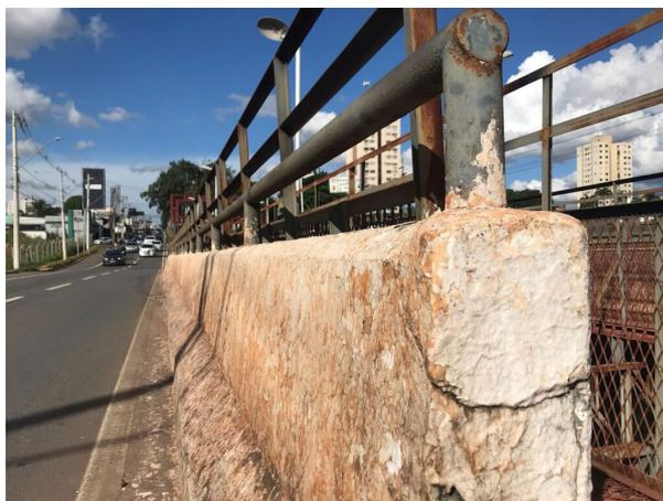
realizadas por engenheiros especializados, apontam a necessidade de intervenções imediatas em parte das estruturas. Entre os principais problemas detectados estão corrosão em armaduras de concreto, trincas
